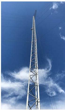
のデータを取るための風況観測塔を設置しています。三角柱の鉄塔で高さが数十メートルあり、西端の観測塔「写真」は重点視点場に指定された村立体育館や冷水峠付近から見えます。
